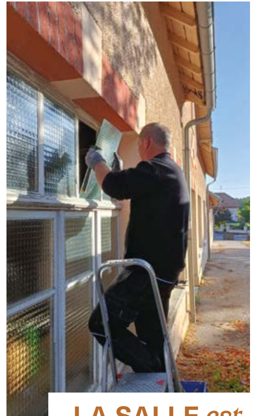
Rénovation fenêtres de la salle du Cercle.
